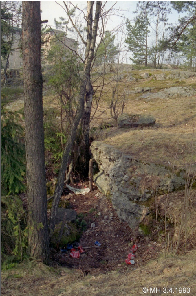
↑ Suojan XXXV:4/5 betonista seinää.
