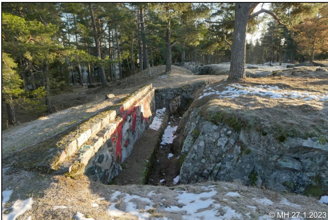
↑ Sisämaan mutkan jälkeen on tyylikäs osuus suoraa ampumahautaa. Ampumakoroke ja panosura löytyy. Valitettavasti löytyy myös seinämä töhryille.
