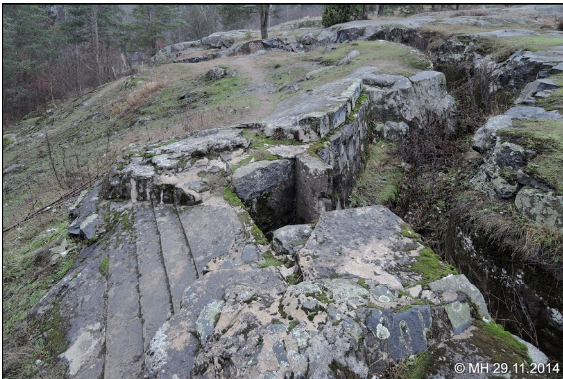
↑ Tuliasema B3. Tyylikäs ja näyttävä B-tyypin asema. Ampumasektorin pohja ja kyljet pykälöity. Asemassa ollut ohut katti on räjäytetty. Asema on hyvällä tähytyspaikalla ja aika pieni kiväärin kanssa toimimiseen, joten lienee tähytysasema.
