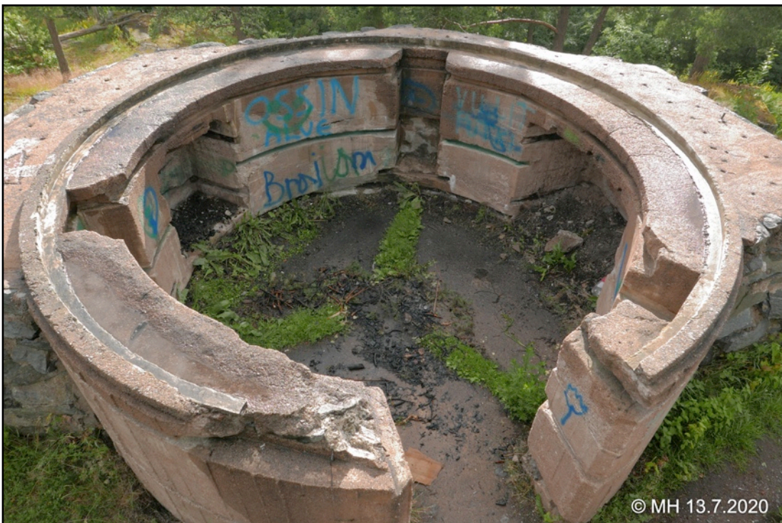
↑ Pohjoisempi konekivääriasema. Muurin päällä oleva betonirengas ylettyi oven yli, mutta on rikottu joskus 70-luvulla. En usko renkaan kuuluneen IT-patterin alkuperäiseen rakenteeseen.
