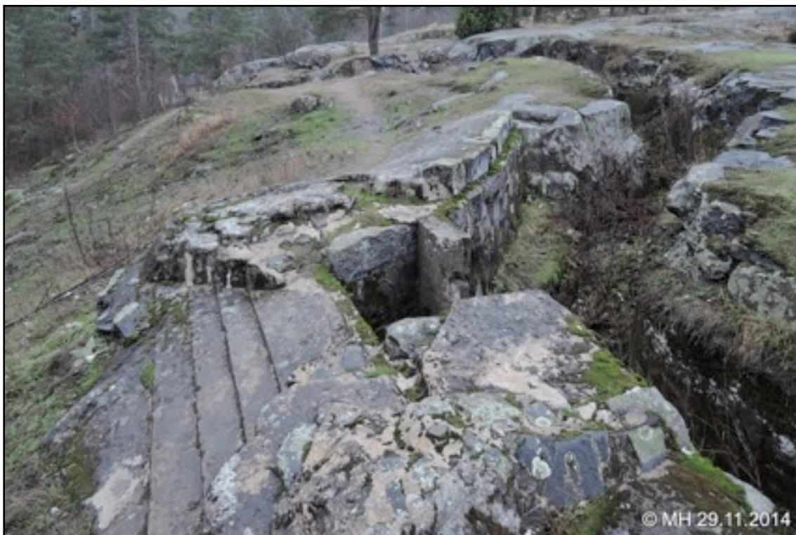
↑ Tuliasema B3. Tyylikäs ja näyttävä B-tyyppin asema. Ampumasektorin pohja ja kyljet pykälöity. Asemassa ollut ohut katti on räjäytetty. Asema on hyvällä tähystyspaikalla ja aika pieni kiväärin kanssa toimimiseen, joten lienee tähystysasema.
