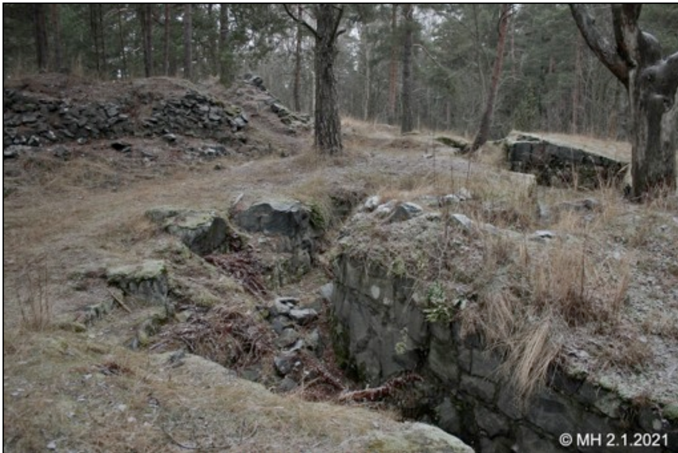
↑ Mäen itälaitaa. Käytävät on louhittu kallioon ja isolta osalta seinämissä on harkkokivimuurausta. Taustalla IT-patterin tykkiasema IV.
