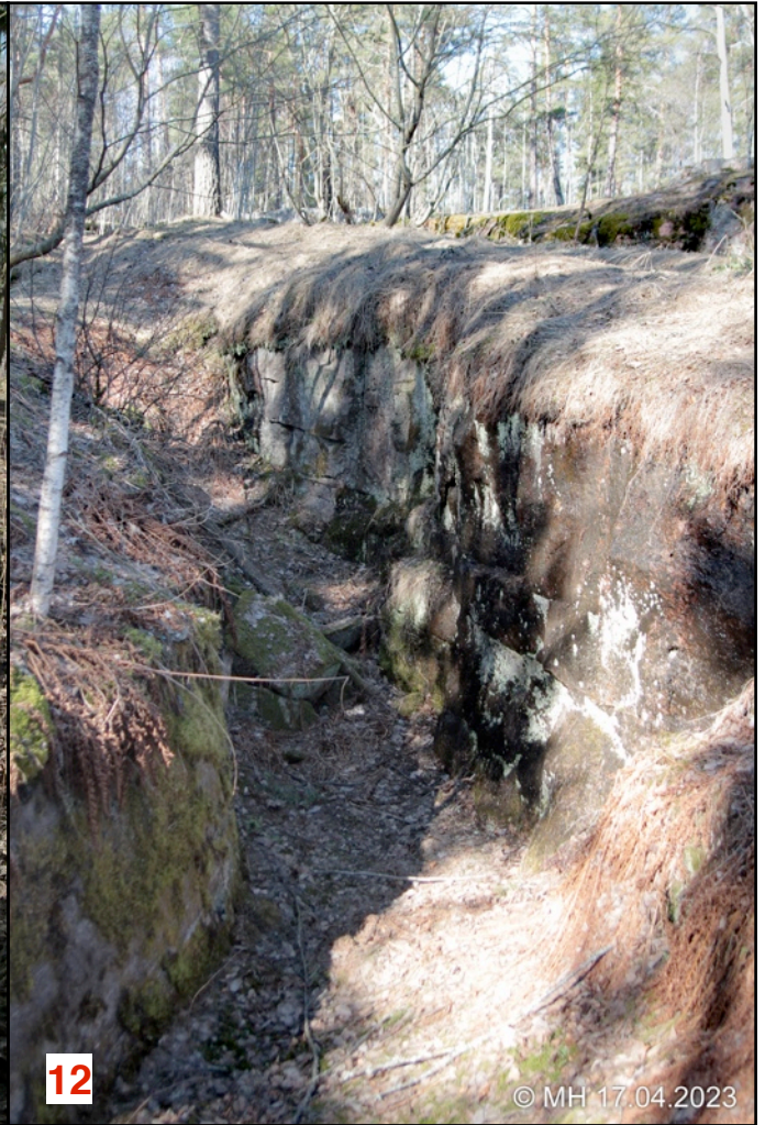
↑ Suojalle 2 nouseva käytävä. Suojaa ei päällepuolelta juurikaan huomaa, pitää tietää.
