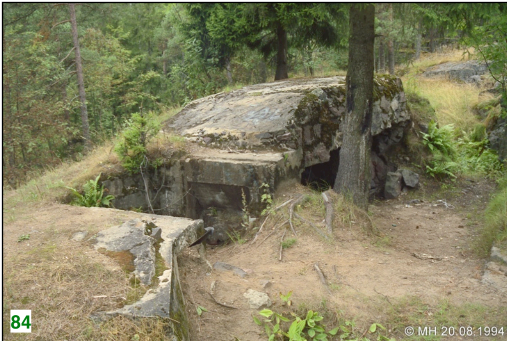
Tuliasema T2 ja suojahuone S2 vuonna 1994. ↑
