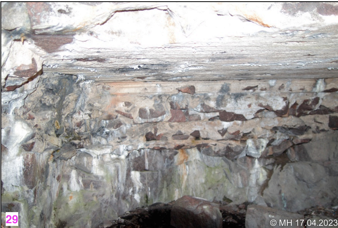
Suojahuoneen S2 sisustaa. ↑
