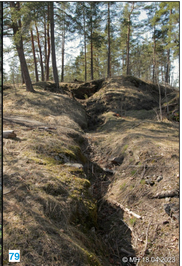
↑ Suojan S7 pohjoinen sisäänkäynti nähtynä saapumiskäytävältä.
