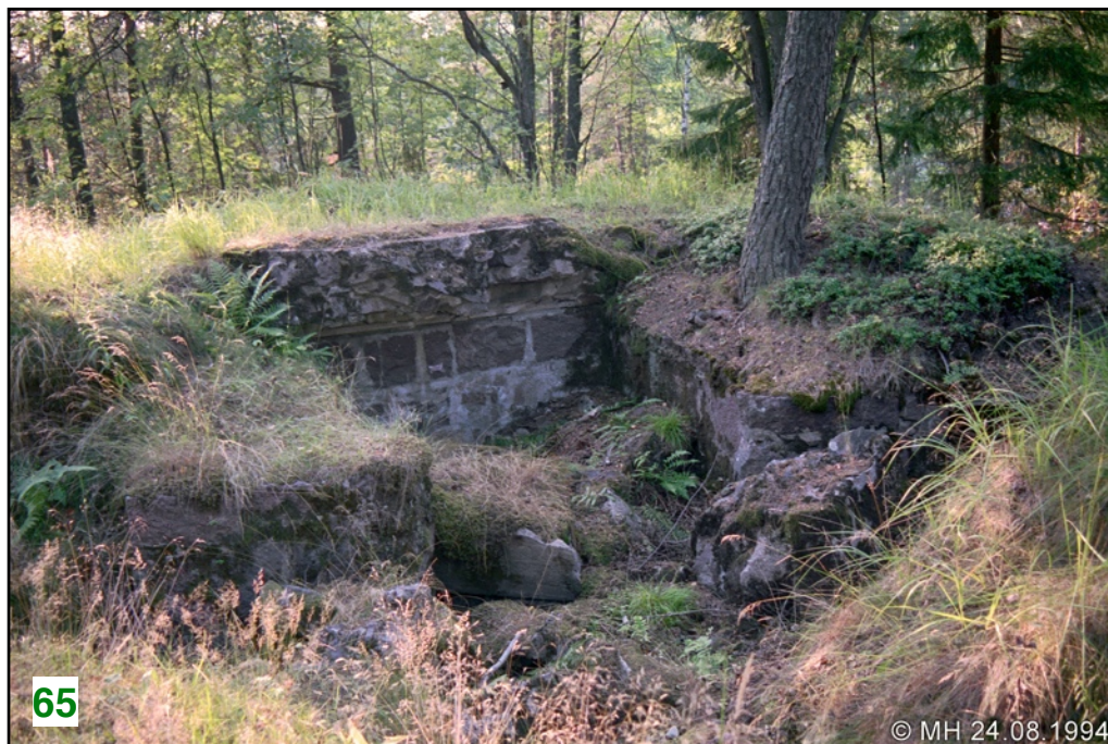
← Harkkokivimuurattu suojahuone S10 .
