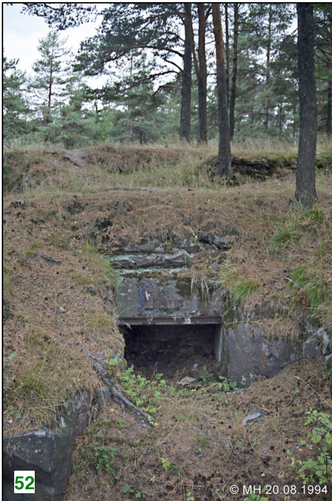
↑ Suojan S7 etelän puoleinen ovi. Aukko on ehjä ja aukon päälläkin kisko tallella.
