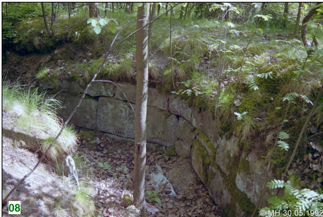
↑ Tyylikästä harkkokivi rakentamista suurista lohkareista.
