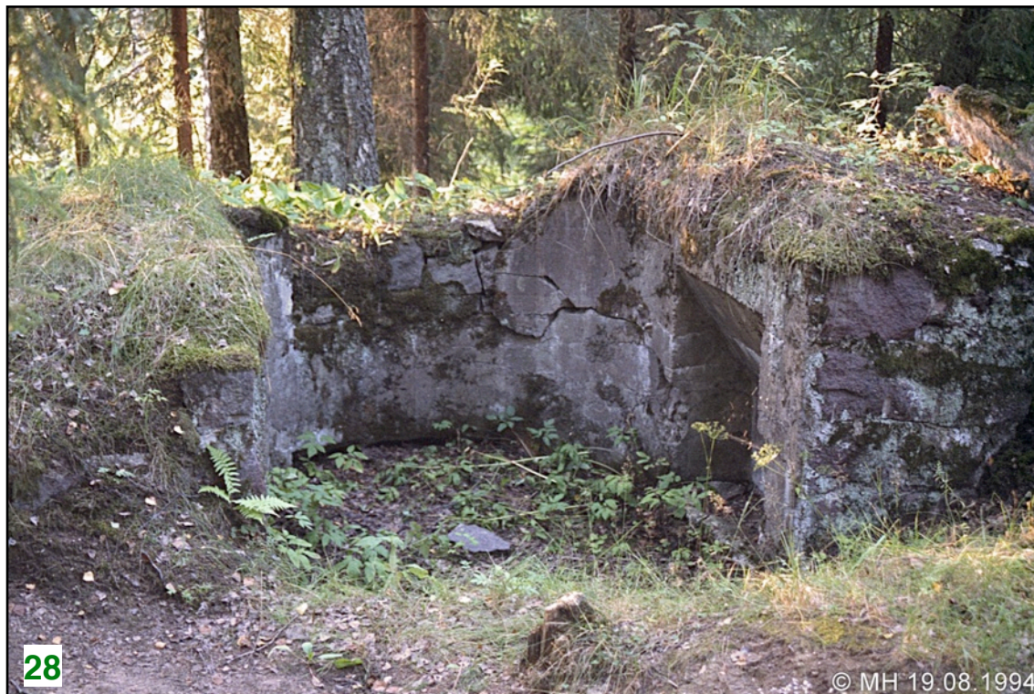
↑ Asema T9. Betonia ilmeisesti säästely halkeamista käytävän puolen harkkovi- vistä päätellen. Ampuma-aukkoakin on pienennetty kivillä.
