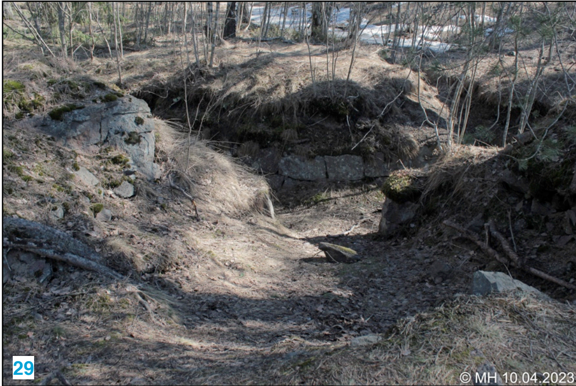
Asema T6 nähtynä ampuma-aukon suunnalta. Ei siis kehuttavassa kunnossa. Maalinnointus Espoossa vihkosen mukaan tässä olisi ollut suojahuone. Mahdollista sekin. ↑
